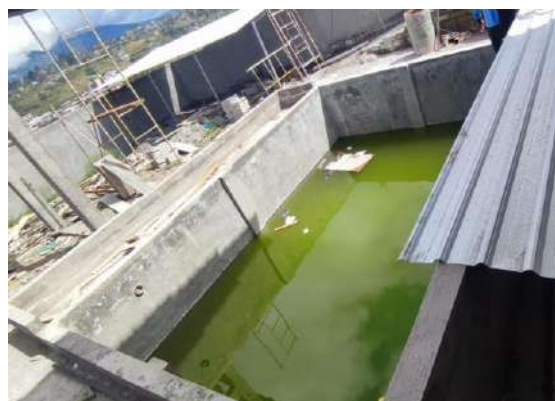
Ilustración 16. Tanque Ecuilizador y Homogeneizador de Aguas residuales provenientes de procesos productivos
