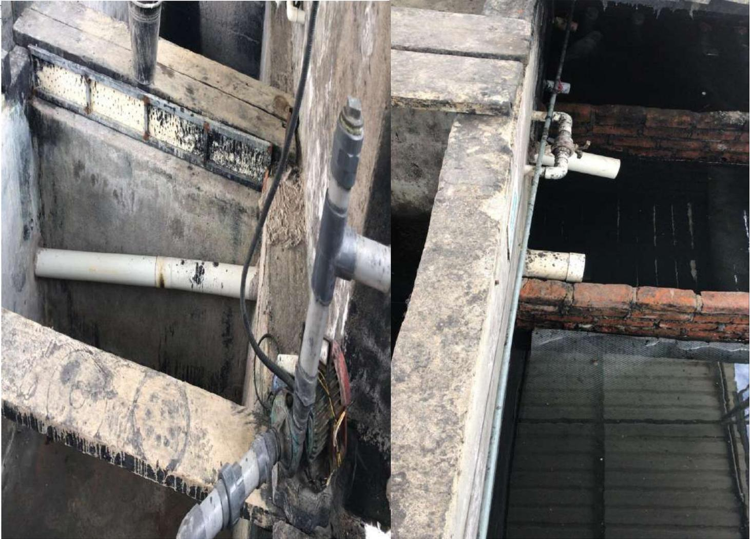
*Figura 12. A) Tubería de transporte de lodos desde el tanque de retención de agua tratada hacia el tanque de almacenamiento de lodos B) Conexión al Tanque de almacenamiento de líquido drenado.*
