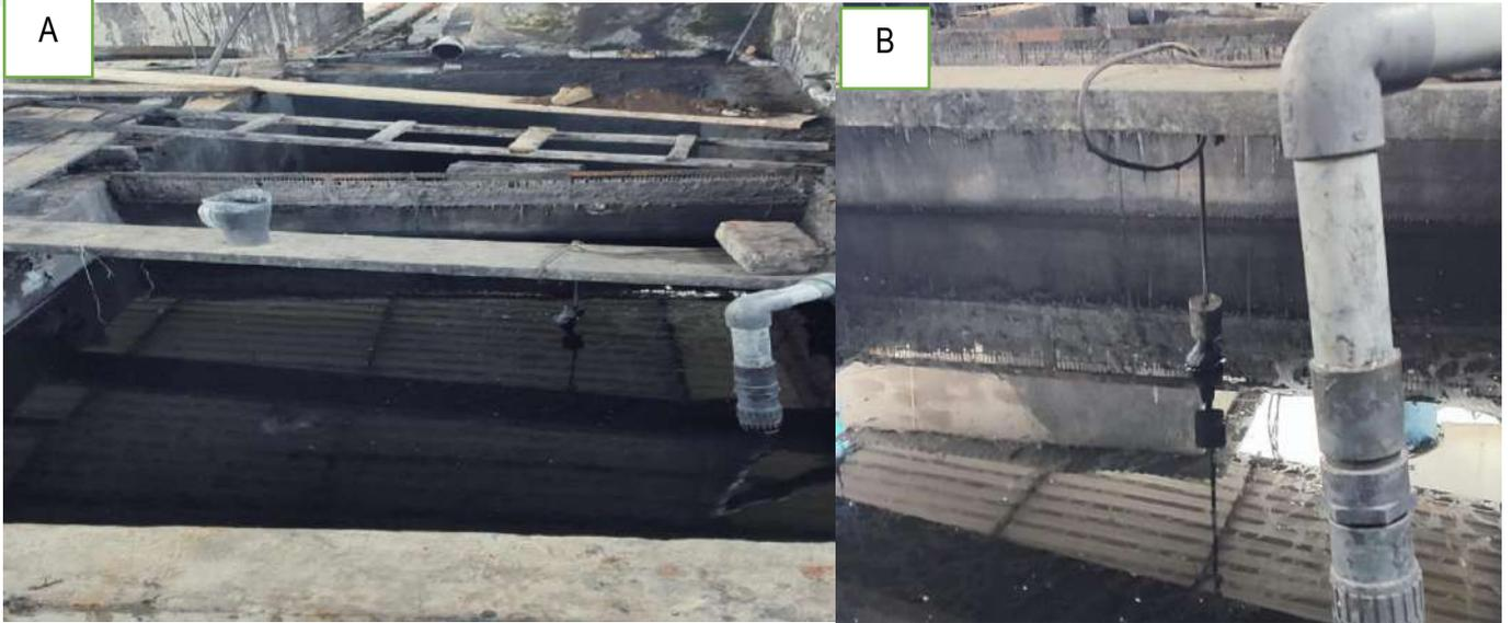
**Figura 4.** A) Tanques de homogenización de Aguas y tanque de sedimentación primaria PTAR "STEAM DENIM" B) Sensor de nivel de agua
