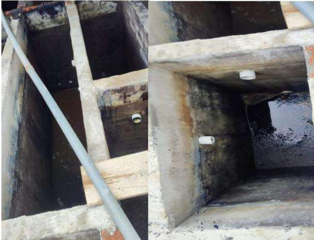
*Ilustración 19. Tanques de dosificación y tratamiento primario del efluente proveniente de la empresa STEAM DENIM*
