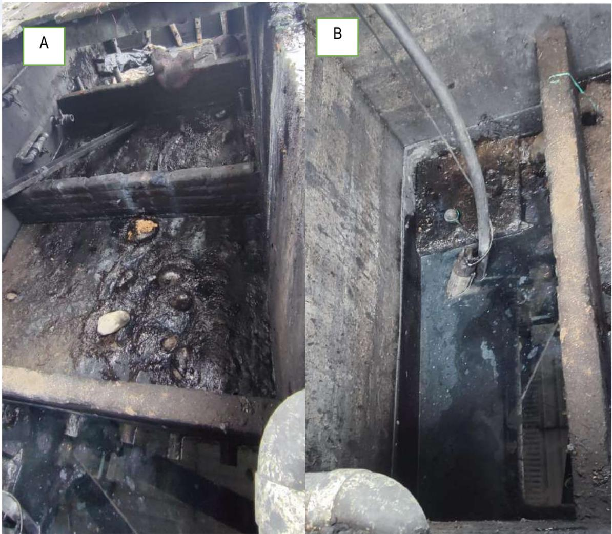
*Figura 12. A) Tanques de secado de lodos B) Tanque de almacenamiento de líquido drenado.*
