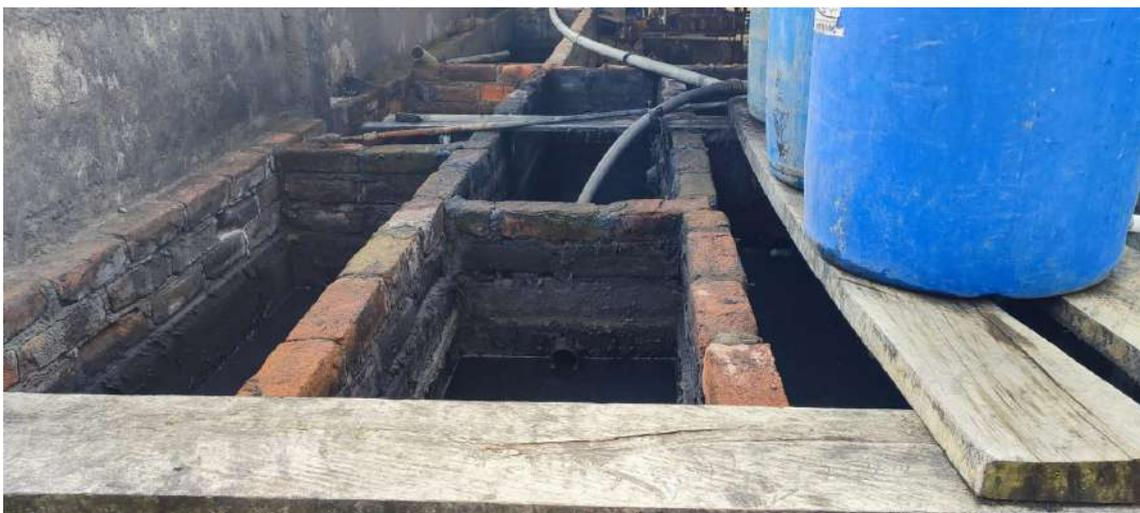
**Figura 7.** Tanques de dosificación y tratamiento primario del efluente proveniente de la empresa STEAM DENIM
