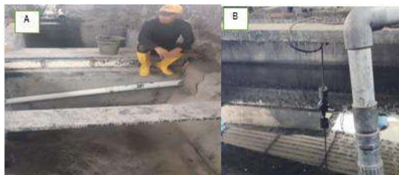
Ilustración 16. A) Tanques de homogeneización de Aguas y tanque de sedimentación primaria PTAR "STEAM DENIM" B) Sensor de nivel de agua
