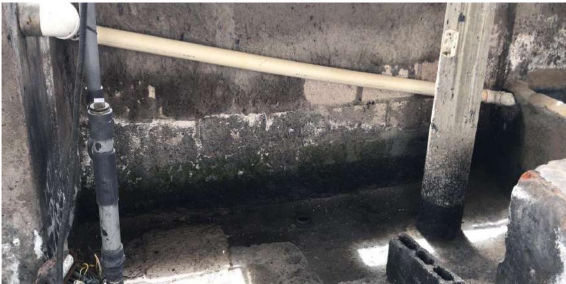
**Figura 14.** Sistema de conexión entre el tanque de retención del agua tratada y el tanque de toma de muestras
