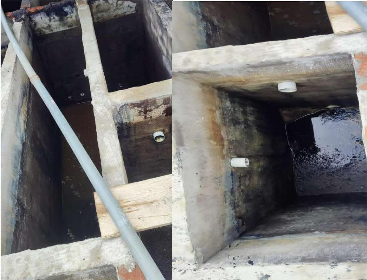
*Figura 7. Tanques de dosificación y tratamiento primario del efluente proveniente de la empresa STEAM DENIM*
