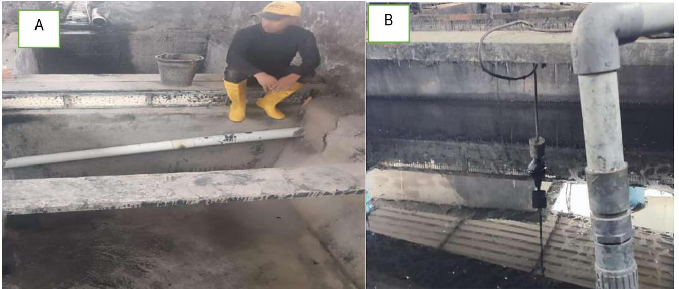
**Figura 4.** A) Tanques de homogenización de Aguas y tanque de sedimentación primaria PTAR "STEAM DENIM" B) Sensor de nivel de agua
