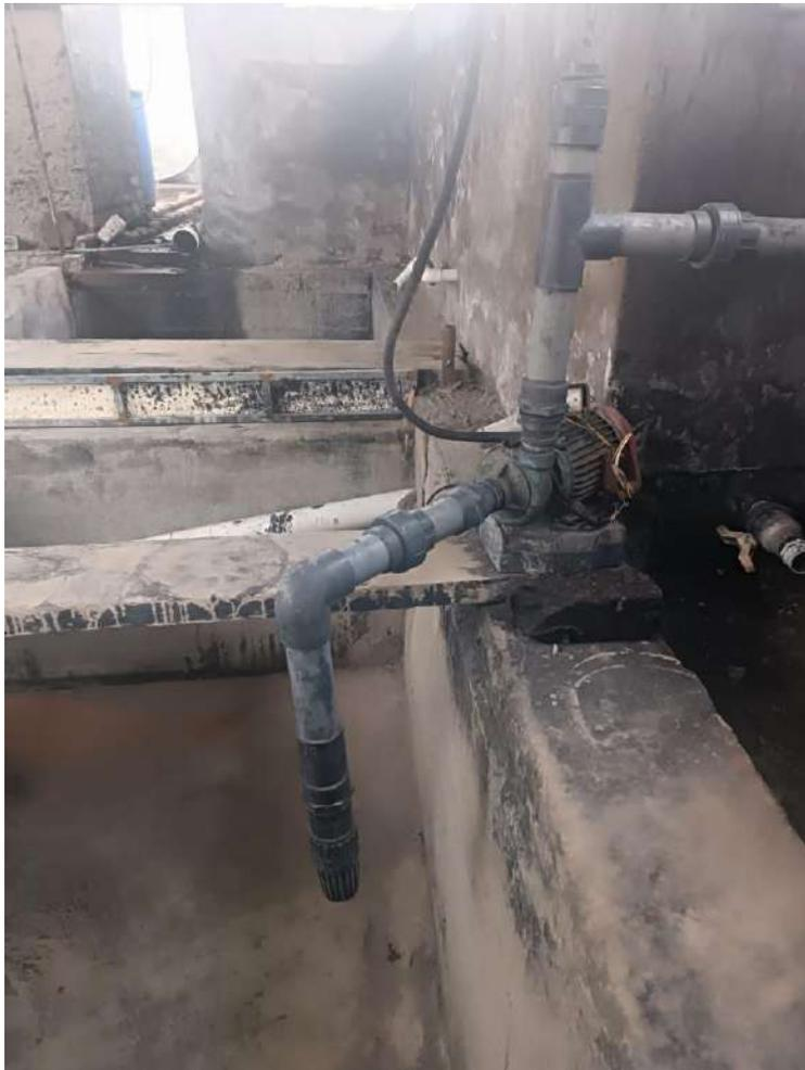
*Figura 5. Sistema de flujo del efluente desde el tanque de sedimentación primario hasta los tanques de dosificación.*
