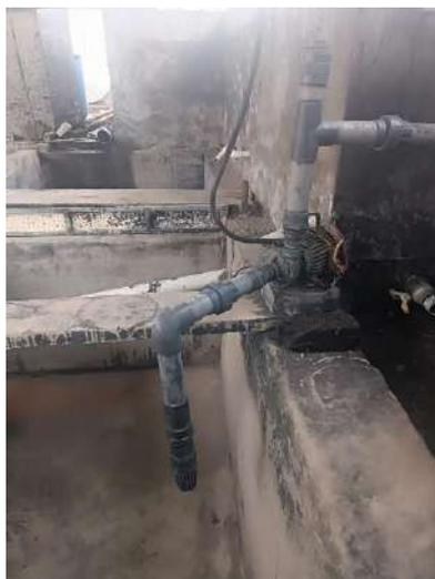
*Ilustración 17. Sistema de flujo del efluente desde el tanque de sedimentación primario hasta los tanques de dosificación.*
