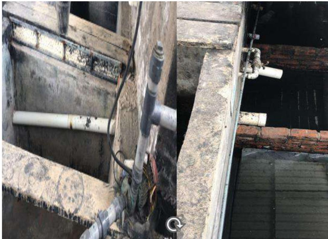
*Ilustración 23. A) Tubería de transporte de lodos desde el tanque de retención de agua tratada hacia el tanque de almacenamiento de lodos B) Conexión al Tanque de almacenamiento de líquido drenado.*
