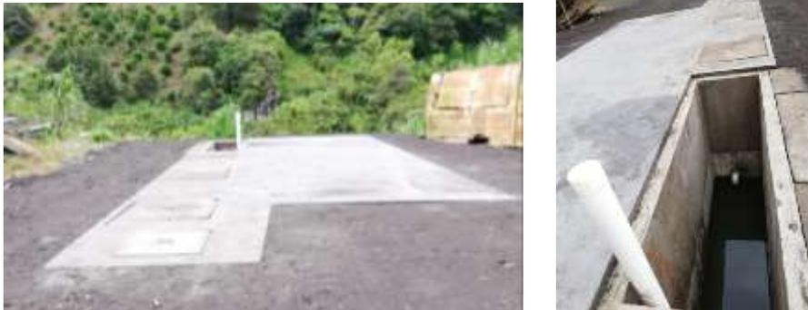
**Fotografía 9. Tanques de sedimentación**
